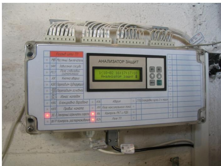
Рис. 2.3. Внешний вид анализатора защит Ан3-03
