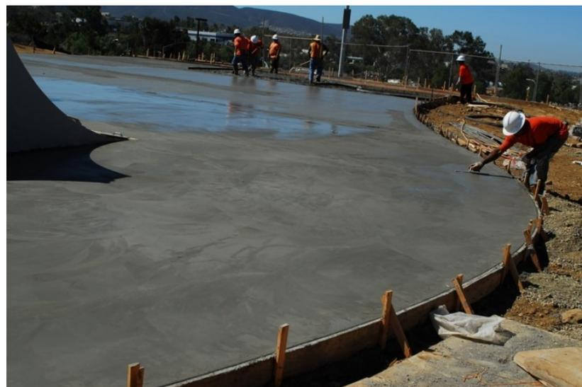
Твердение бетона в естественных условиях
