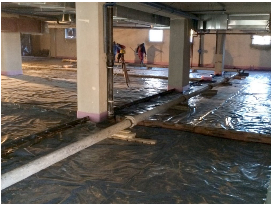
Заливка бетона с помощью дополнительных бетонопроводов (трассы)
