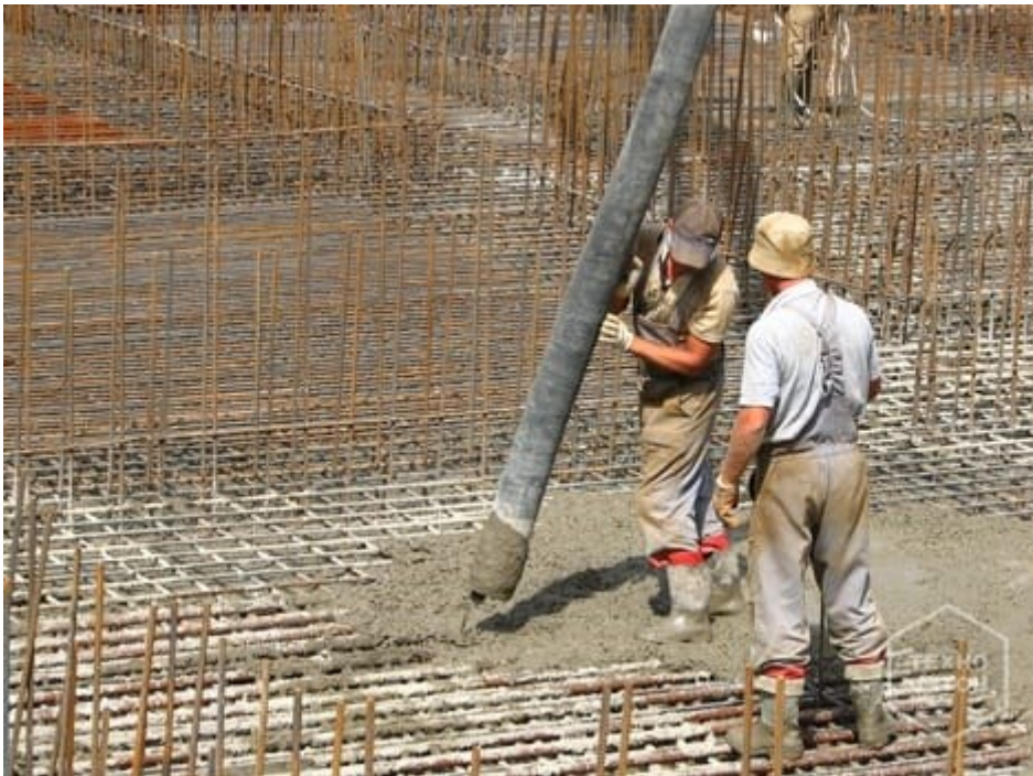
Для работы со шлангом насоса достаточно одного человека
