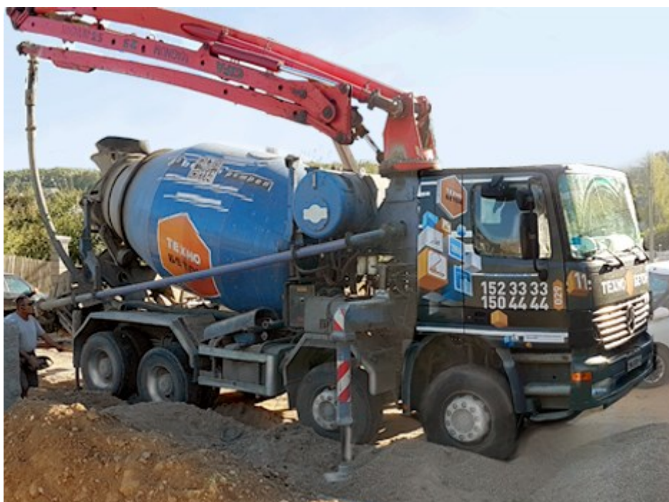
Миксер-насос доставляет бетон на объект и заливает его с помощью стрелы
