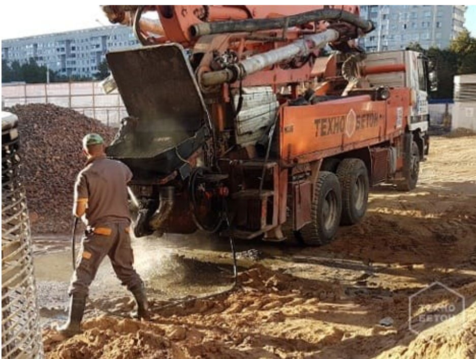
Промывка насоса происходит на объекте сразу после заливки бетона
