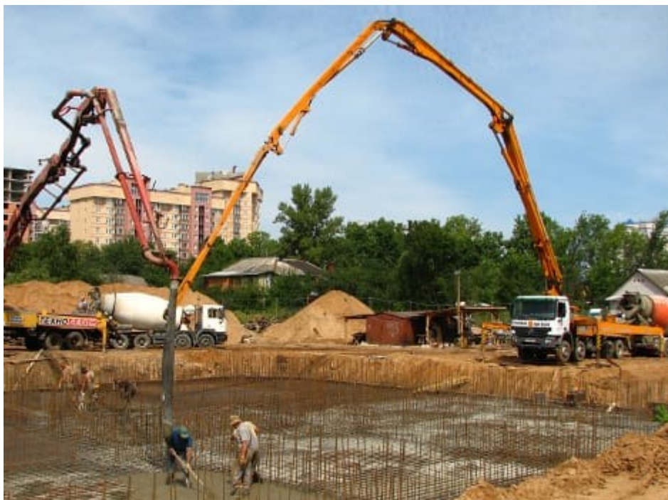
Автобетононасос работает на заливке фундамента
